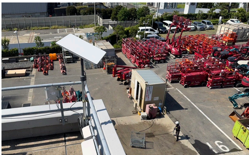
東京 DL センター センター棟屋上 設置風景
