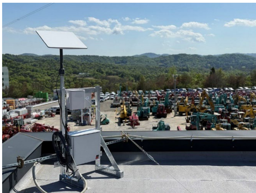
広島テクノパーク統括工場 事務所棟屋上 設置風景
